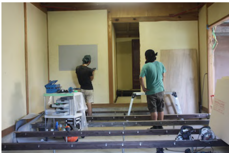
・大引を設置して家具職人の友人と窓枠の打ち合わせ、窓の取り付け場所の壁を切る。
