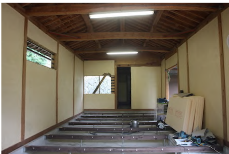
・壁を切り取った状態
