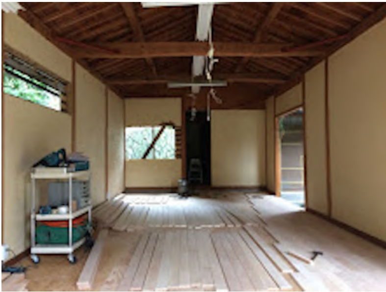
・床材を借り貼りして、本貼りする
