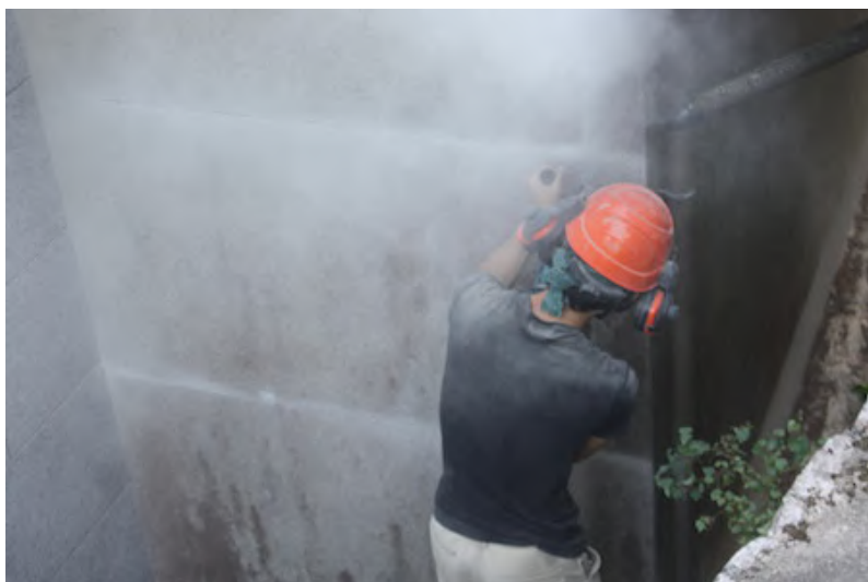
・グラインダーで外壁をで切る、
