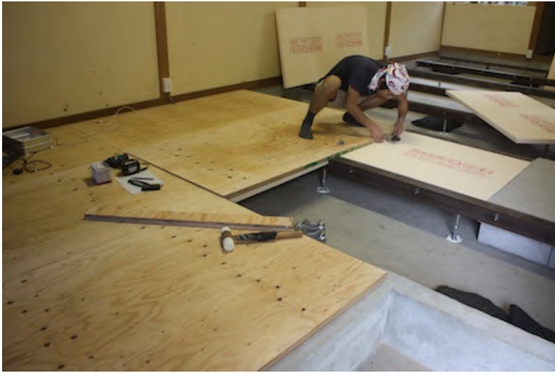
・断熱材を入れて合板を貼る。
